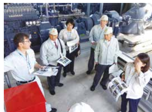
下野排水機場視察の様子
