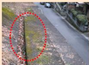
擁壁の上にある排水溝の詰まり
