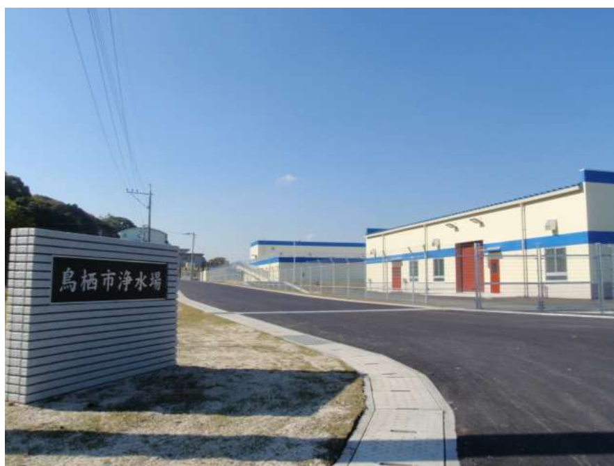
鳥栖市浄水場（鳥栖市原古賀町）
