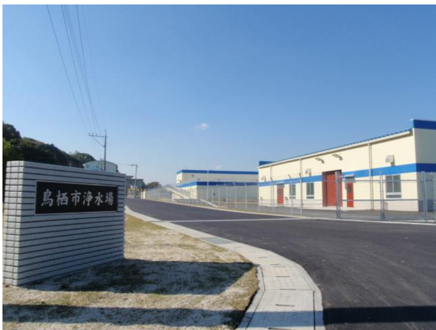
鳥栖市浄水場（鳥栖市原古賀町）
