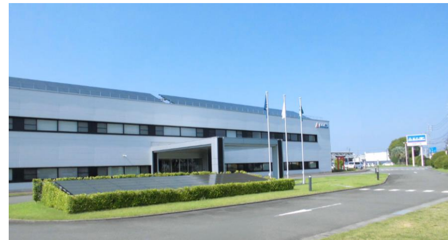
写真:事務厚生棟・太陽光パネル
