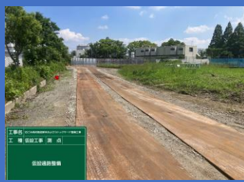
仮設通路設備
