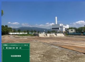
仮設通路設備
