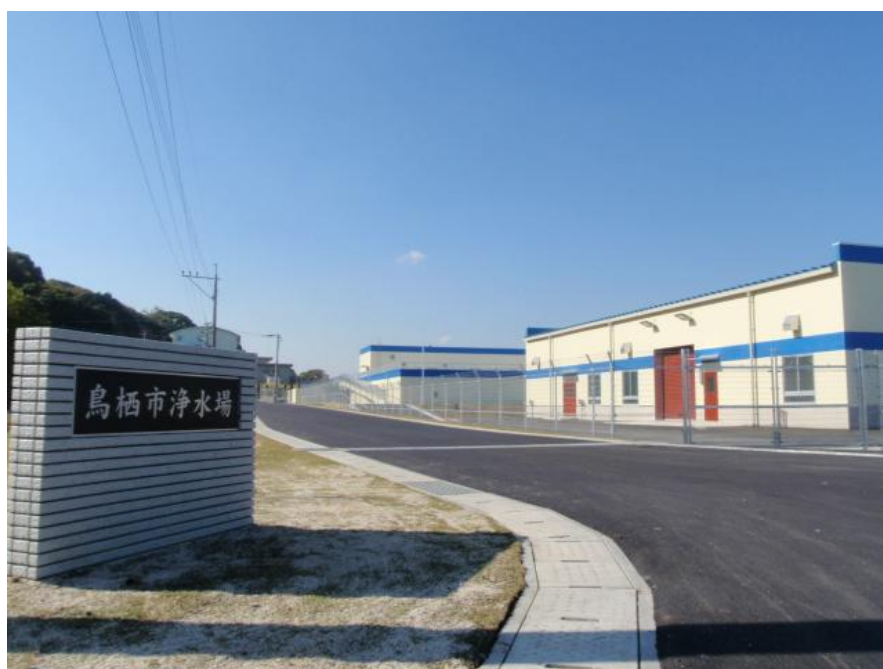
鳥栖市浄水場（鳥栖市原古賀町）
