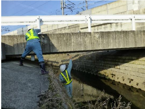
定期点検の状況
