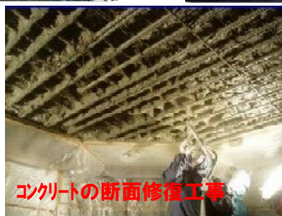
コンクリートのひび割れ補修工事
