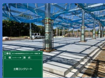
土間コンクリート
