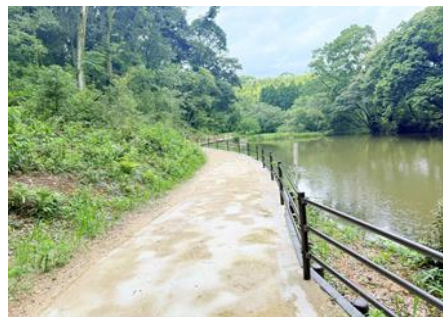
東公園防護柵
