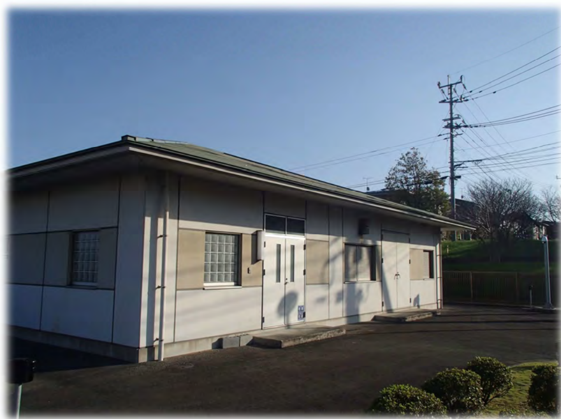
北部中継ポンプ場
