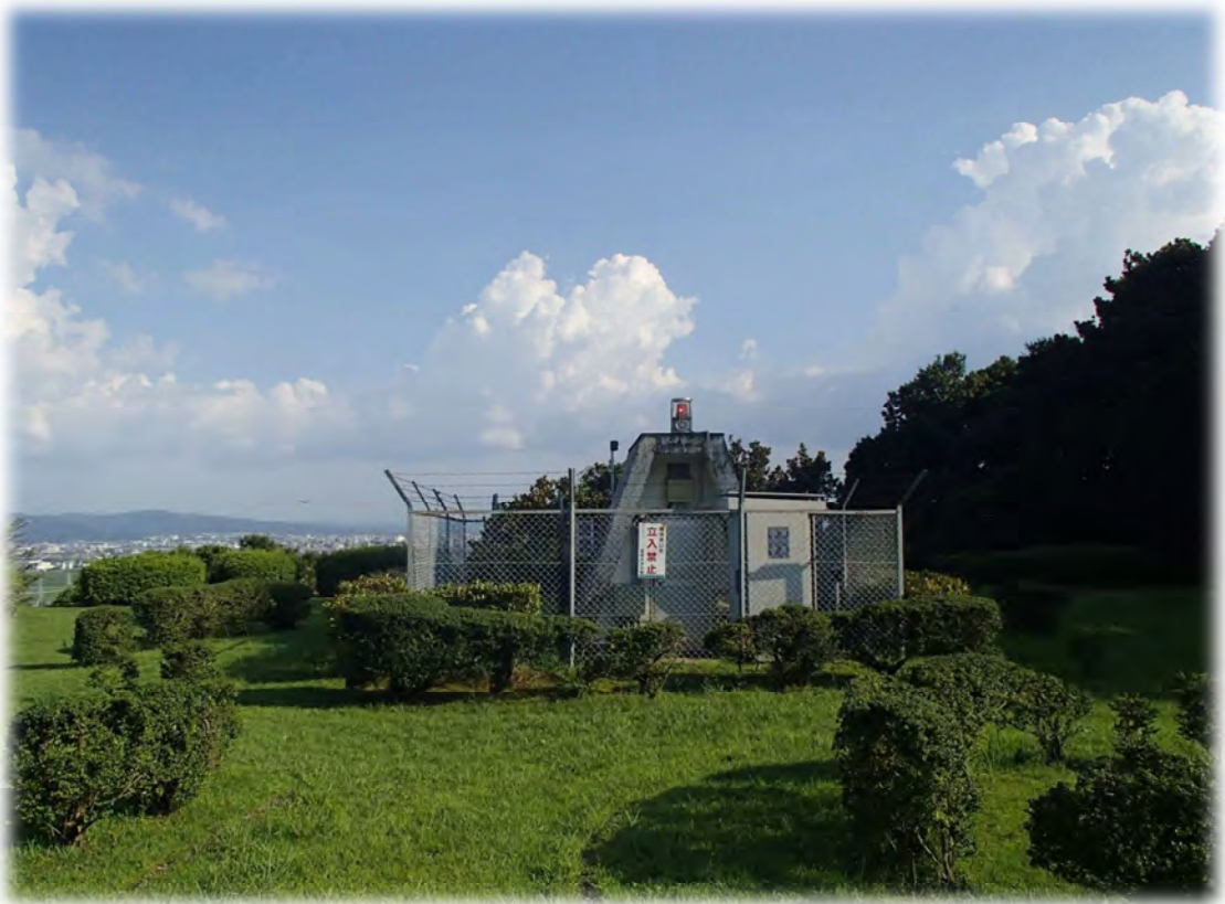
朝日山第2配水池
