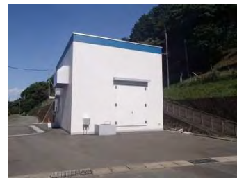
自家発電機棟
