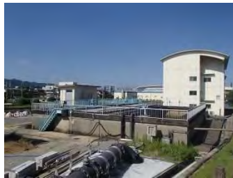
排水池、濃縮槽兼排泥池
