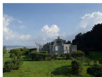
朝日山第2配水池
