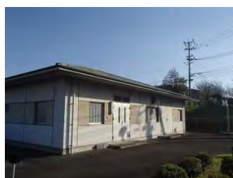
北部中継ポンプ場
