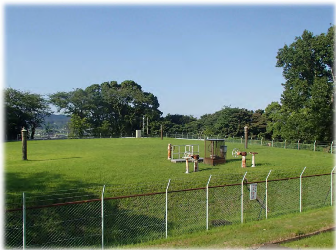
朝日山第 1 配水池
