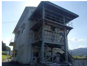
汚泥脱水機棟
