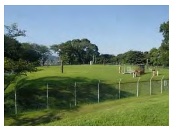
朝日山第1配水池
