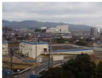
浄水池兼配水池
