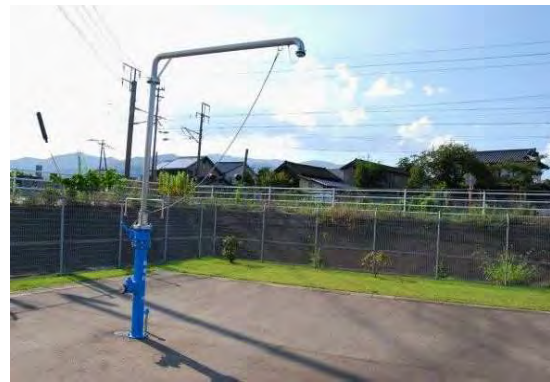
鳥栖市浄水場内に設置されている応急給水栓
