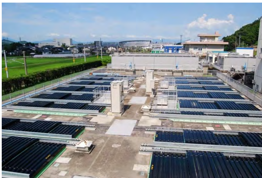
鳥栖市浄水場
