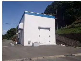
自家発電機棟
