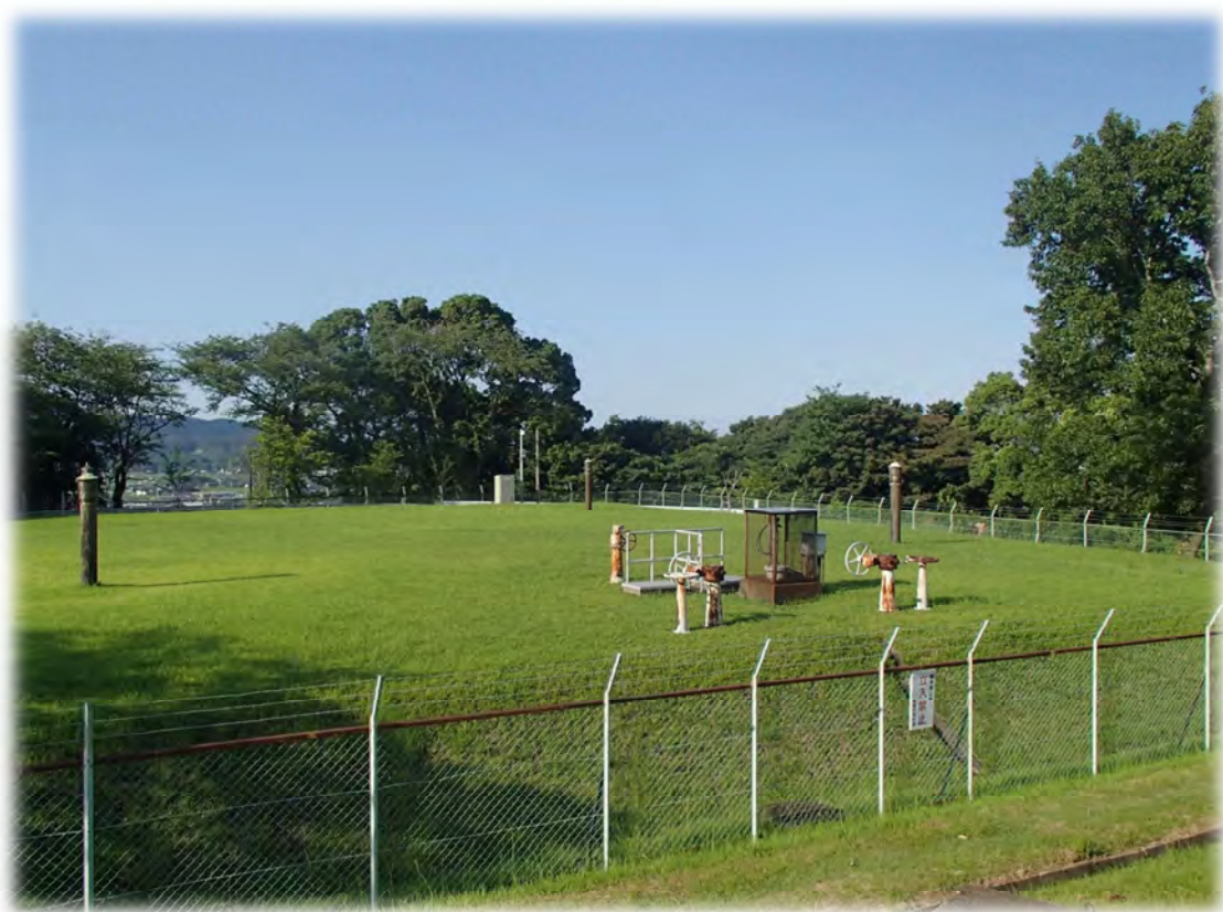
朝日山第 1 配水池
