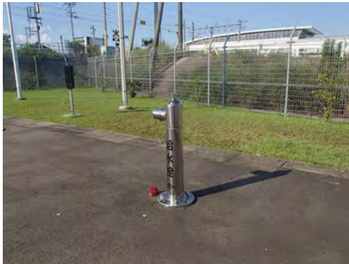
鳥栖市浄水場内に設置されている応急給水栓
