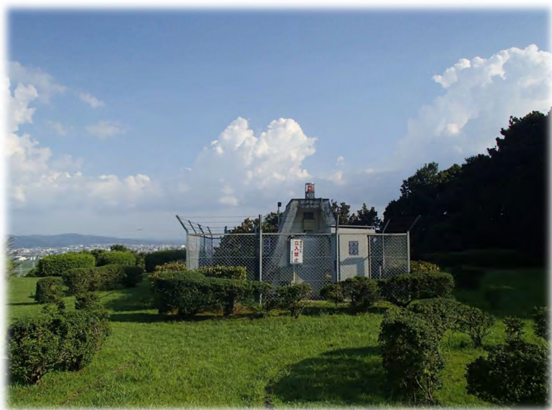
朝日山第2配水池
