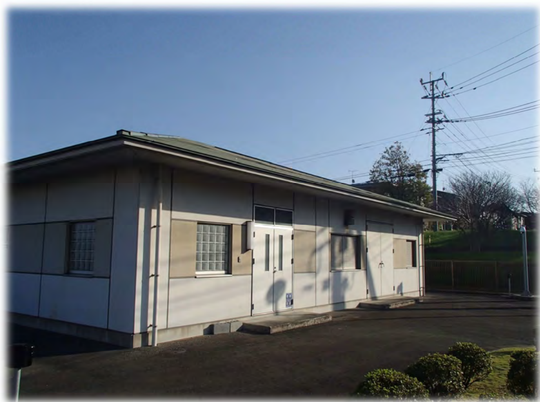
北部中継ポンプ場
