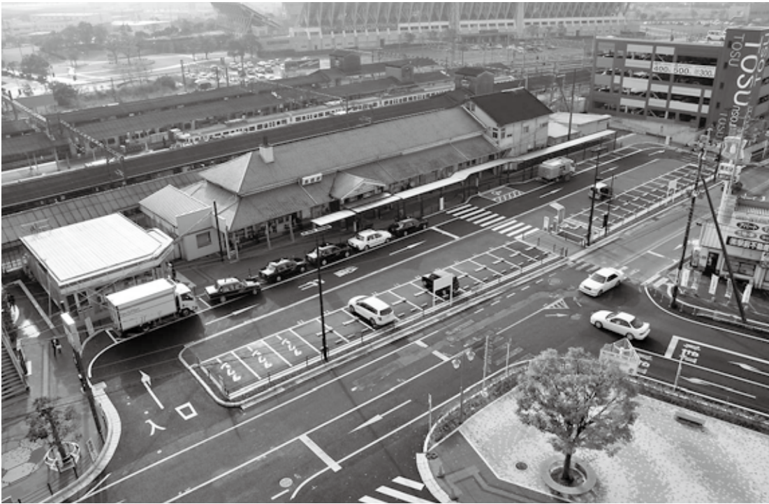
整備後の鳥栖駅前周辺の様子
