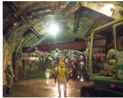
筑紫トンネルの工事(平成15年9月)
