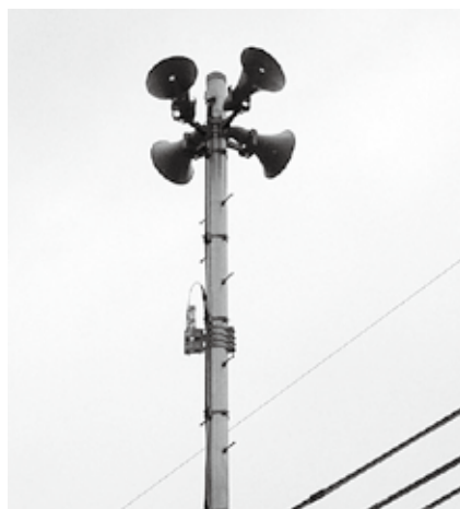
消防団格納庫などに設置しています
