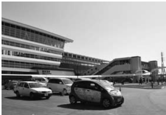
整備された新鳥栖駅前
