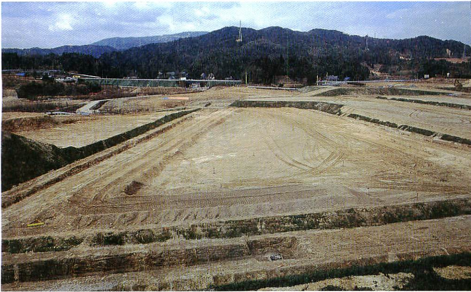
造成工事が進む集団移転用地
