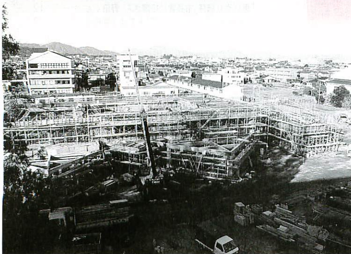
来年3月の完成を目指して工事が進む高齢者福祉施設
