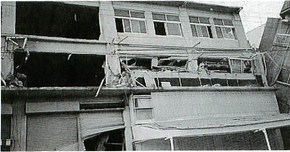
昨年1月17日に起きた阪神・淡路大震災の様子。 火災で焼失した街、倒壊した家屋、2階部分が 押しつぶされたビル(昨年2月17日市職員撮影)
