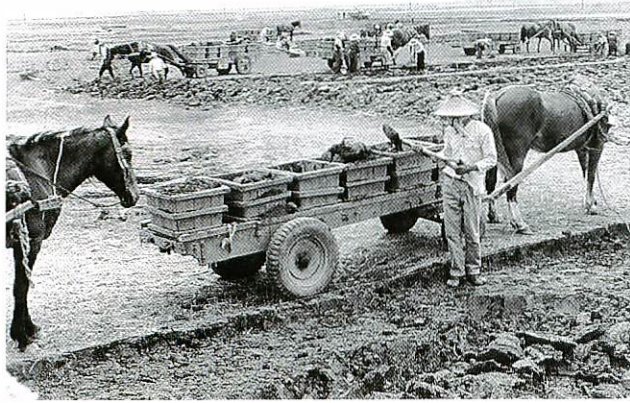
土砂の運搬に馬車を使っていた圃場整備工事（昭和35年ごろ）
