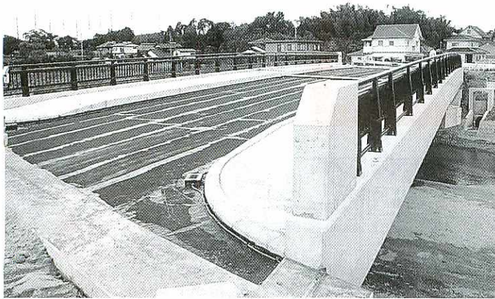
架け替え工事が進む安良川橋
