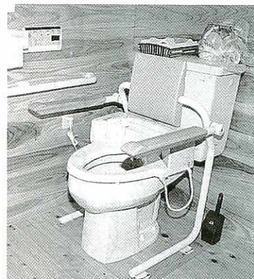
洋式便器にして、手すりなどをつけた高齢者住宅改良工事の例
