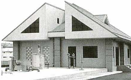
千歳地区農業集落排水施設が通水
