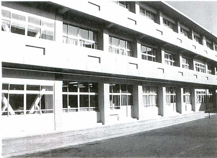
大規模改造工事を終えた鳥栖中学校（普通教室棟）
