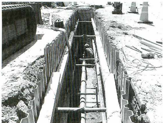
着実に進む下水道の汚水管きょ工事（曾根崎町）
