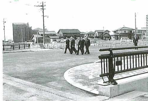
交通量増加が見込まれる鳥の里橋
