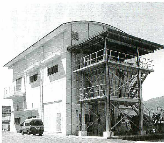
浄水場内に完成した最新の排水処理施設
