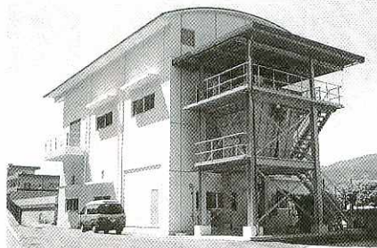
浄水場に排水処理施設が完成
