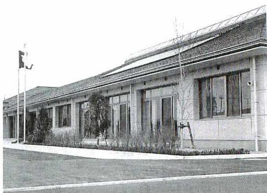
完成した「若葉コミュニティセンター」
