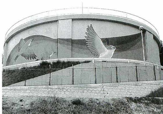
鳥栖北部丘陵新都市内に完成した配水池
