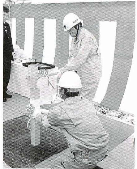
九州新幹線・中心杭の打ち初めをする牟田市長(原古賀町)
