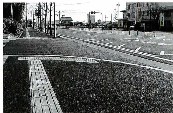
改良された市道布津原町・本鳥栖線
