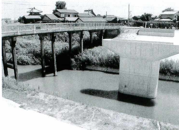
架替工事が進む水屋橋
