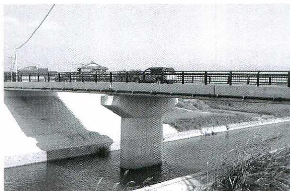
架替工事が完了した水屋橋
