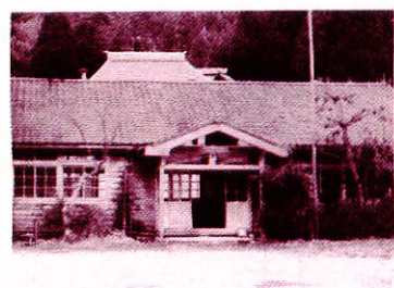
▲河内小が解体される
