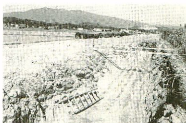
◎国営附帯県営かんがい排水事業鳥栖地区を起工(12/2)
