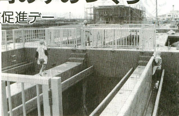
○真木町に建設中の下水道終末処理場
