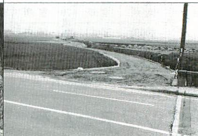
石橋川道路新設工事 1,692万円
