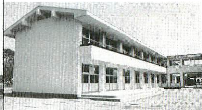
麓小学校特別教室改築工事 1億6,139万9,000円
