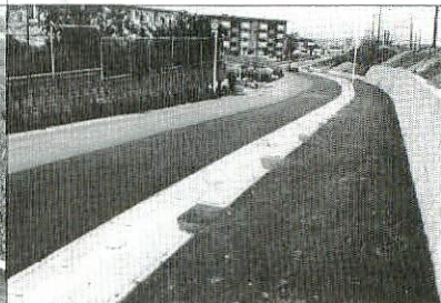
轟木・酒井西線交通安全施設工事 1,714万6,000円
