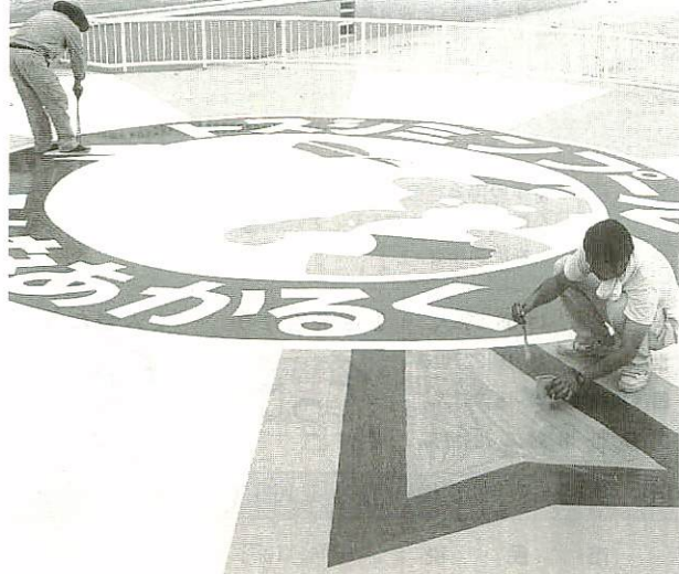
○市民プール絵書き工事
