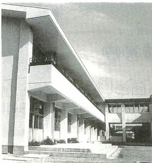
○菰小学校特別教室改築工事
