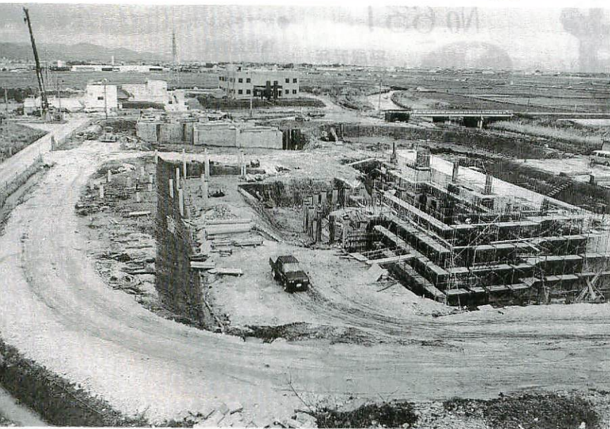
〇急ピッチで進む下水道終末処理場の建設工事
