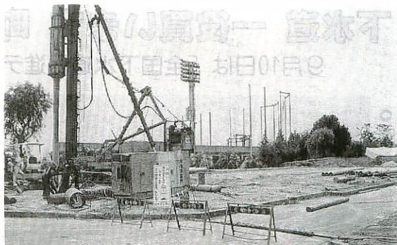
〇勤労青少年ホーム多目的ホールの建設工事
