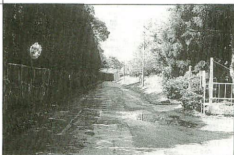
緊急地方道路整備事業（轟木・村田線）
