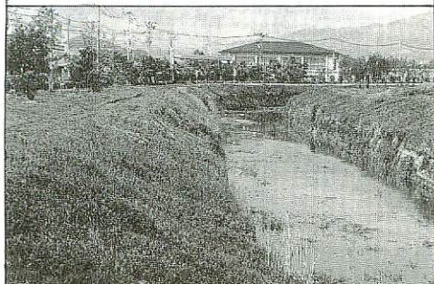
コスモス道路整備事業（大木川右岸600m）
