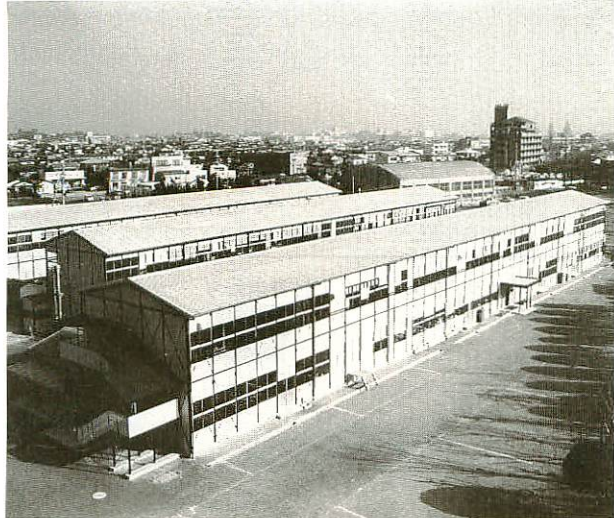
鳥栖北小学校仮設校舎
