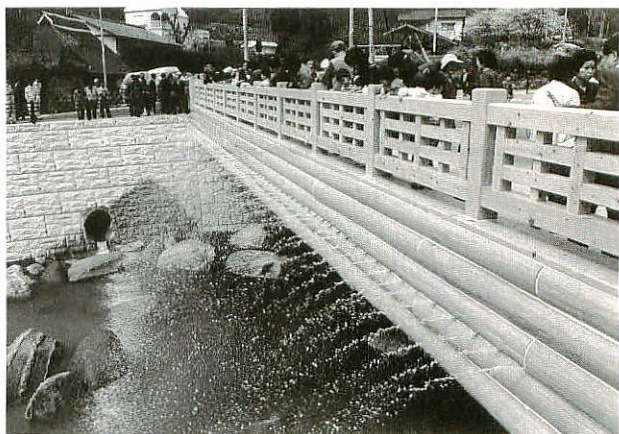
橋げたから勢よく放水するシャワーブリッジ
