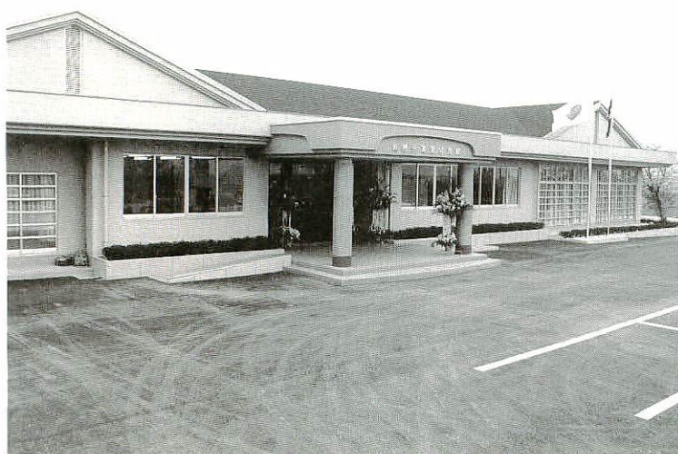
玄関にスロープと自動ドアを設けるなど身障者にも配慮した基里公民館
