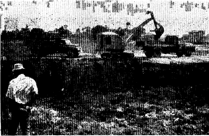
沈砂池ができる新宝満川ぞいの 工事現場
