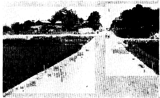
幅7メートルの原町農道
