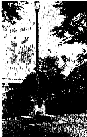
お宮の境内につくられた簡易焼却炉(酒井西町)
