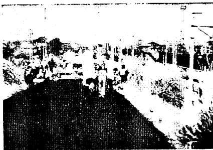
防じん舗装工事 (松原町)
