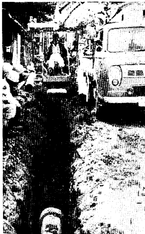
上水道の配水管設作業 (幸津町)
