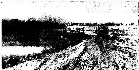
上 「月の輪工法」の手並みをみせる市消防団幹部 下 三島町の干拓現場(5月11日写す)
