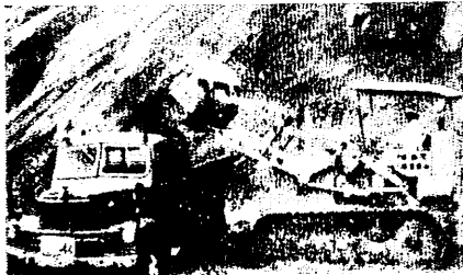
採石場で活躍するローダー・ショベル
