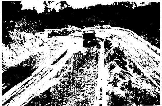
開通した河内ダム 付替道路
